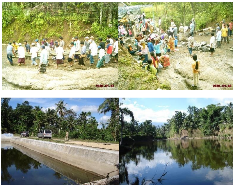
Gambar 1: Atas, masyarakat bergotong royong secara bergiliran termasuk kaum ibu saat pembangunan bendungan di desa Jenggik utara, Kabupaten Lombok Timur, NTB. Bawah bendungan jenggik utara sebagai penampung air untuk pengairan sawah seluas 420 ha.
